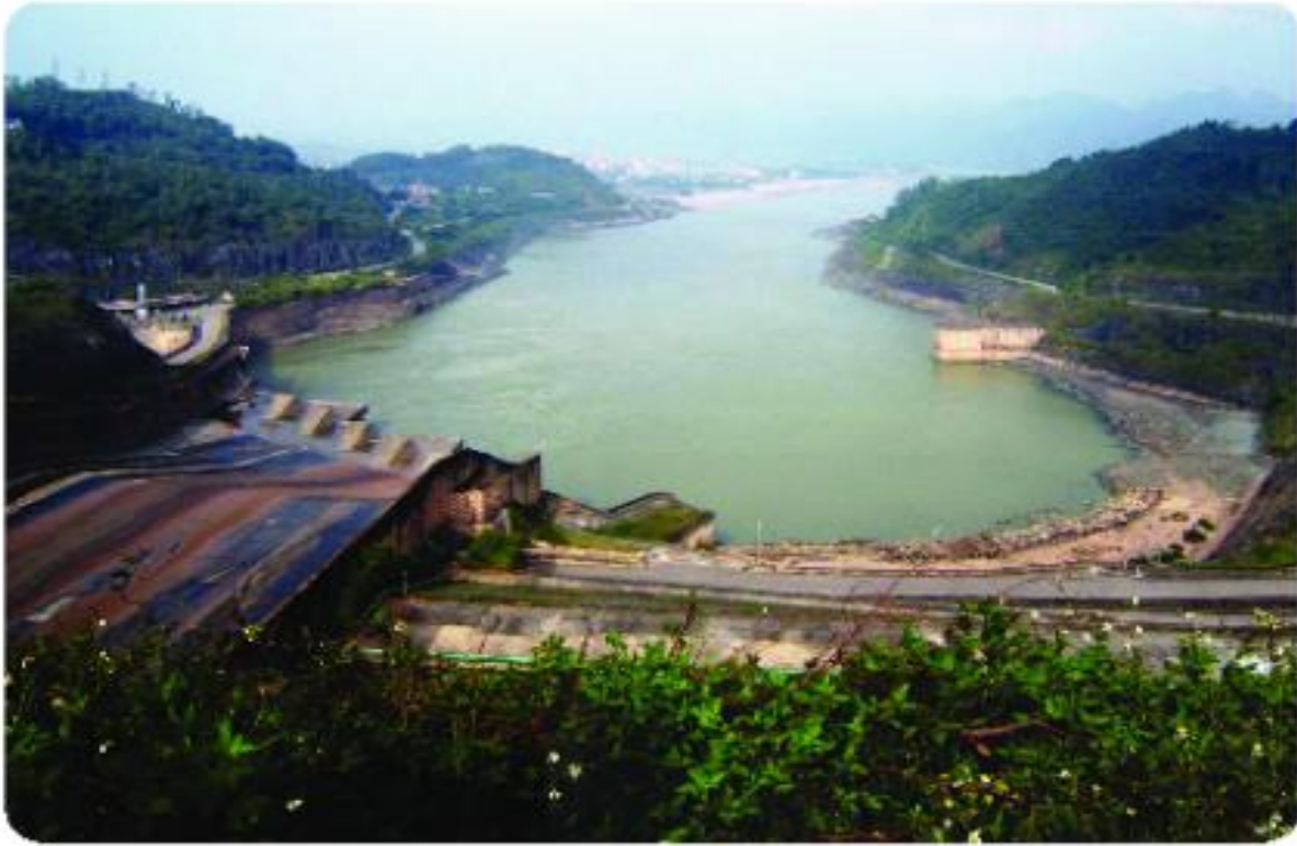
Đập thủy điện
